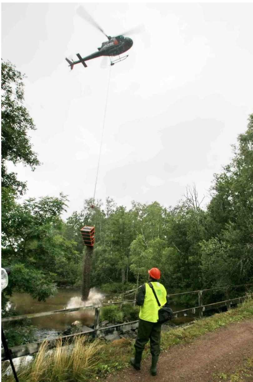
Att utveckla och förbättra vattenkvaliteten inom SydostLeaders vattenområde genomförs på olika sätt. Här läggs lekgrus ut med hjälp av helikopter. Foto Ingmar Elofsson
